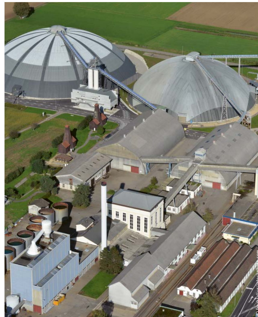
Die Schweizer Salinen in Riburg versorgen eine Gourmetshrimps-Produktion mit überschüssiger Energie und Salz. Der Salzproduzent zählt in Sachen Energiemanagement auf die Zusammenarbeit mit der EnAW.
